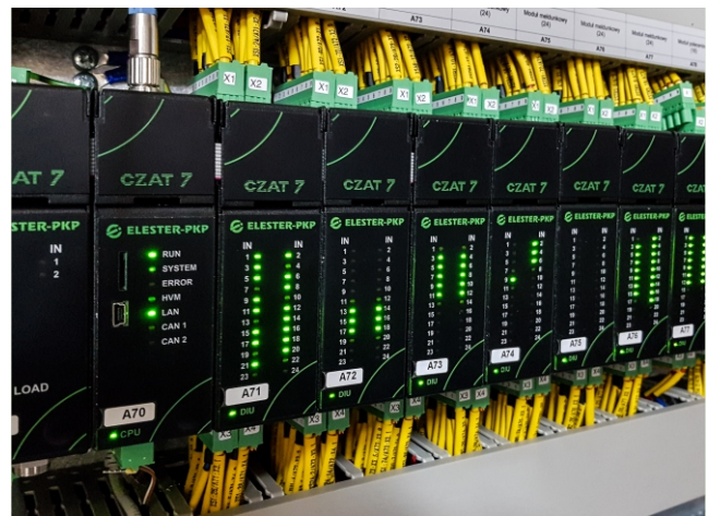
Zestaw modułów sterownika CZAT7 umieszczonych w Siłowni SIL
