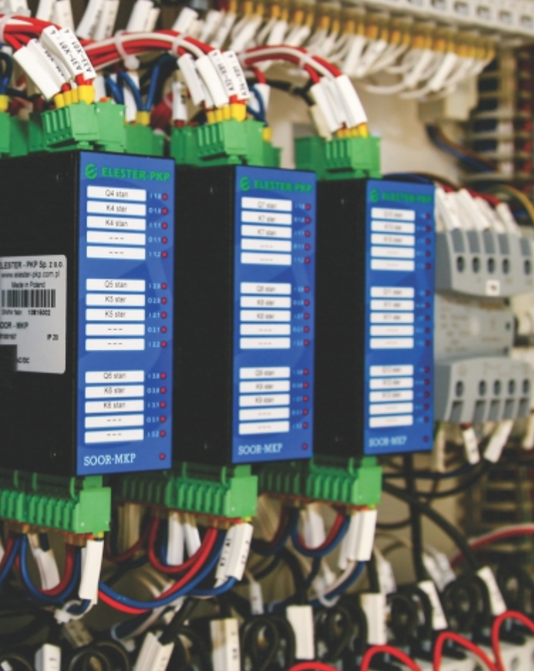
Dedykowany dla systemu sterowania ZNOR2 zestaw sterowników w skład którego wchodzi: modułu centralny SOOR-MS oraz moduły kontrolno-pomiarowe SOOR-MKP, obsługujące poszczególne obwody zasilające.
